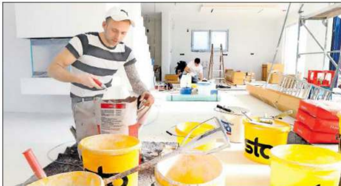
Firmenchef Mario Graf arbeitet auf der Baustelle selbst mit. Der Kundenkontakt ist ihm wichtig. FOTO: IVERSEN
