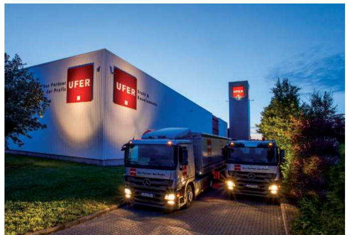
Das Lager für Stahl und Bauelemente in Landau
