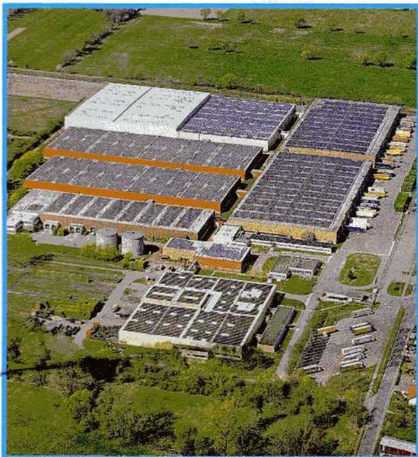
Michelin setzte bei der Eröffnung des neuen Betriebsgebäudes auch auf Solartechnologie. (Foto: stp)
